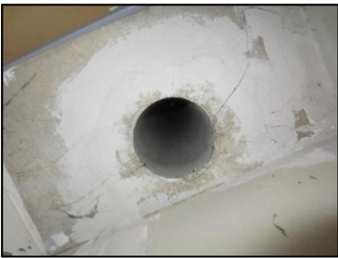
Photo N° 1198 AMIANTE CIMENT - -placards technique gaz +3 Conduits Ventilation haute (Fibres-ciment)
